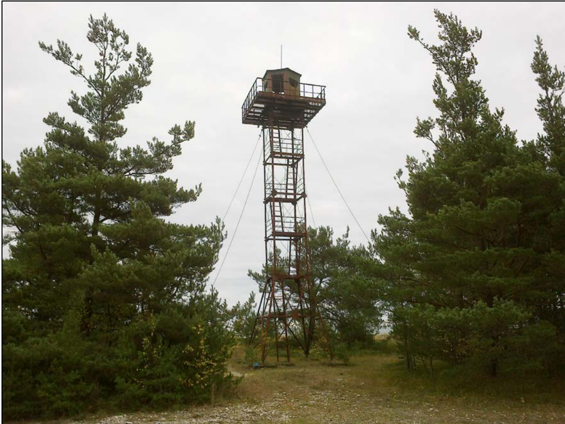
Foto 9. Lehtma tehnilise vaatluse post. Lehtma vaatetorn on ainus täismetallist konstruktsiooniga torn Hiiumaal, sellepärast praegu väga heas korras, vajaks ainult värvimist. Foto Ain Tähiste 17.10.2013.
