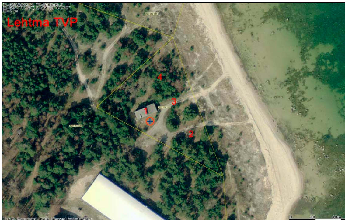
Skeem 3. Lehtma tehnilise vaatluse post. Allikas: Maa-ameti Geoportaal
