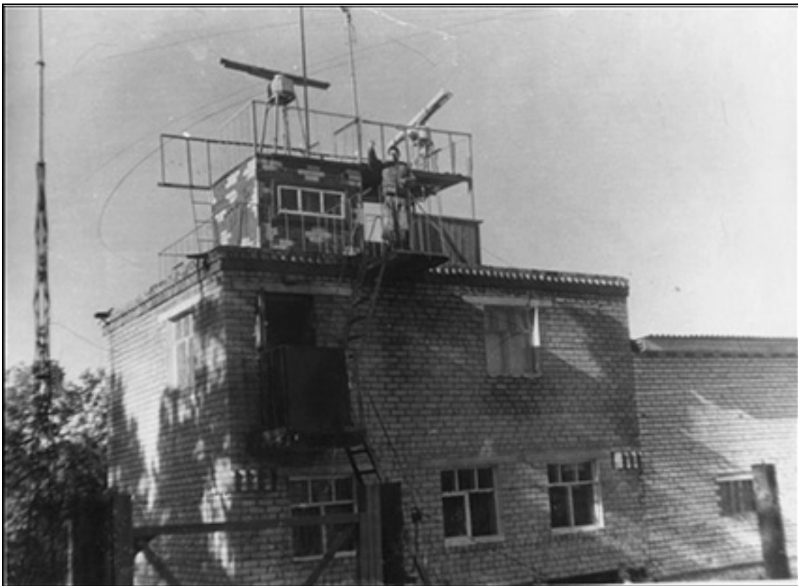
Foto 15. Lehtma tehnilise vaatluse post. 1986. aastal vaatluspost moderniseeriti - juurde ehitati prožektori angaar (paremal) ja katusele teine radariantenn. Vasakul raadiomast, mille vundament säilinud. Foto saidilt http://www.pogran-zastava.ru (vaadatud 25.09.2013).
