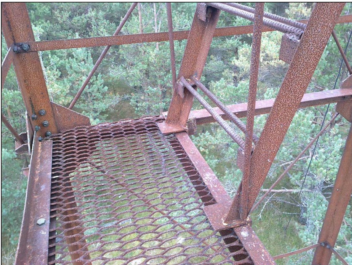
Foto 10. Lehtma tehnilise vaatluse post. Vaatetornide tavaliselt kõige nõrgem osa on puidust vahepõrand, millele kinnituvad metalltrepid. Lehtmas on vahepõrandad metallvõrgust. Foto Ain Tähiste 17.10.2013.
